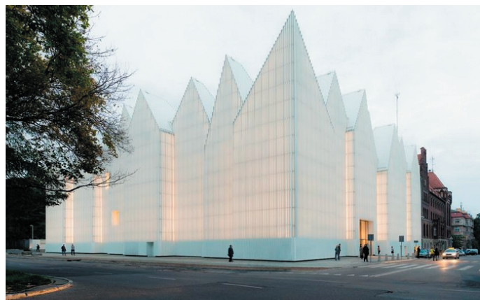
Budynek filharmonii szczecińskiej otrzymał nagrodę UE w dziedzinie architektury współczesnej im. Mies van der Rohe w 2015 r.
